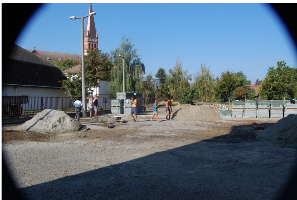
Udvari burkolat készítésének munkálatai
